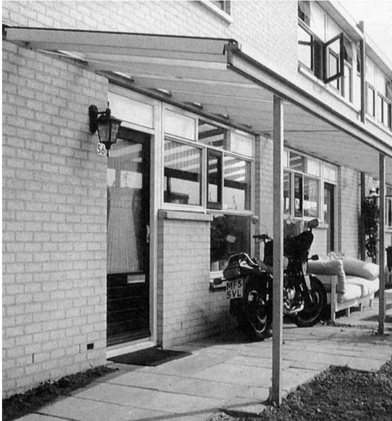
© Herman Hertzberger, in: H. Hertzberger: Vom Bauen, München 1995 (S. 56), Siedlung Het Gein, Amersfoort / NL (Architekt: Herman Hertzberger, 1989)
